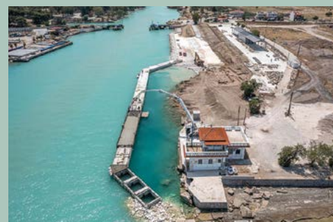
Κατασκευή λιμενοβραχίονα. The construction of the breakwater.
