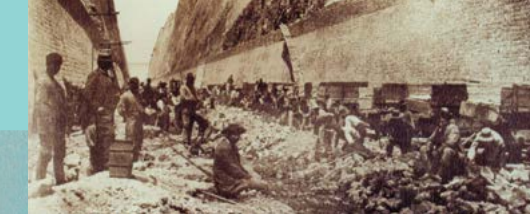
Εργασίες διάνοιξης της Διώρυγας. Works during the construction of the Canal.
