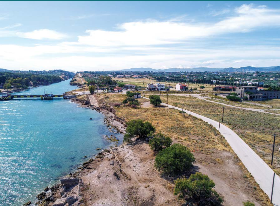
Ο χώρος του Διόλκου κατά την έναρξη των εργασιών. The Diolkos site at the commencement of works.
