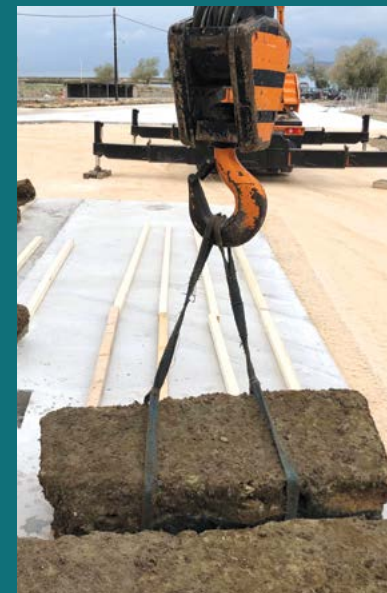
Τοποθέτηση λιθόπλινθων σε εργοταξιακό χώρο. Handling of ancient ashlars at the worksite.
