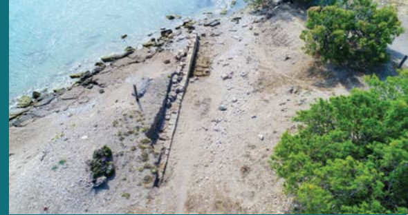
Η κατασκευή με το λίθινο δάπεδο (έναρξη εργασιών). The stone floored structure (initial stage of the project).
