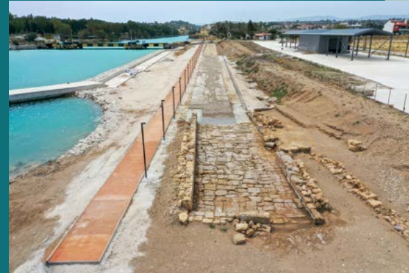
Η κατασκευή με το λίθινο δάπεδο (Μετά το πέρας των εργασιών). The stone - floored building (Completion of works).
