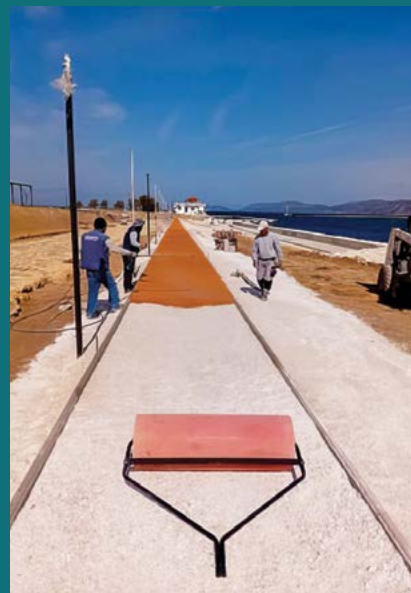
Κατασκευή διαδρόμου επισκεπτών. Construction of the visitors path.
