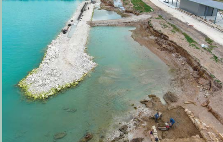
Ρίψη λιθορριπής. Riprap placement.
