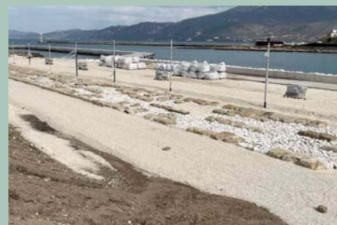
Εργασίες αποκατάστασης. Restoration works.
