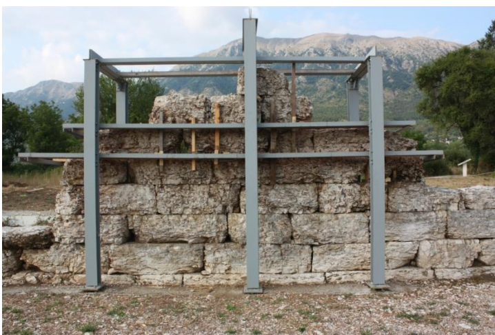
Εικόνα 5: Στερέωση αποκατάσταση της τοιχοποιίας της δυτικής στοάς του Ιερού
