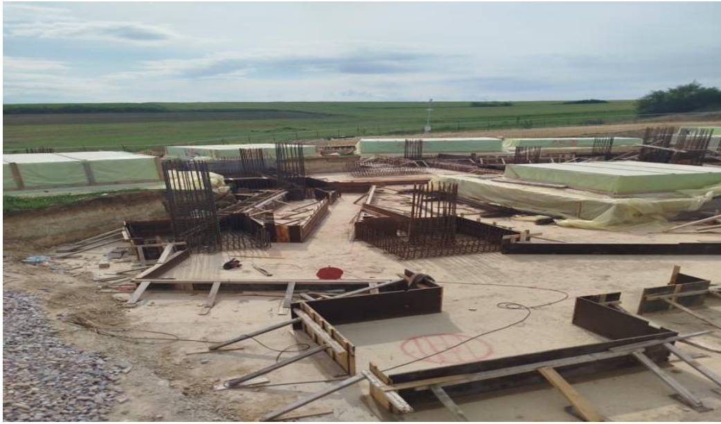
Απομάκρυνση πρόχειρων στεγάστρων και εργασίες θεμελίωσης
