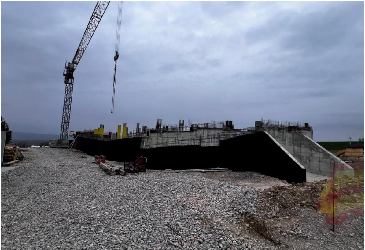
Εργασίες δόμησης κελύφους
