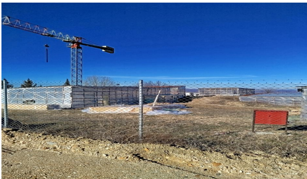
Εγκατάσταση γερανού και εργοταξίου
